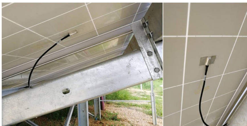
Figura 30: PT-1000 Fixado na Parte Traseira do Módulo
